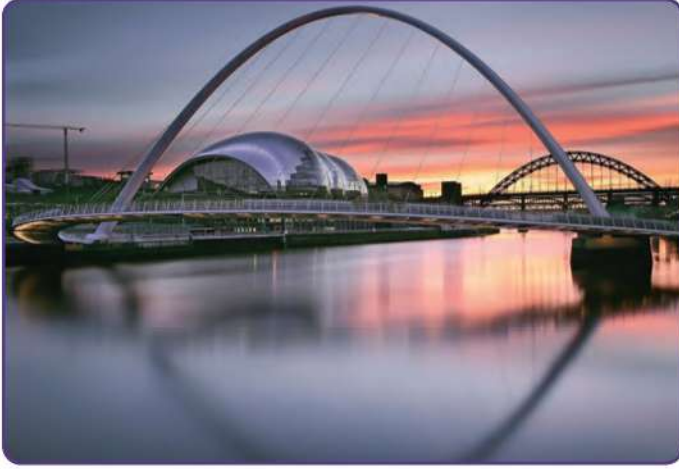
جسر المشاة (إنفينيتي) شمال إنجلترا
