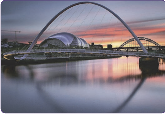
جسر المشاة (إنفينيتي) شمال إنجلترا
