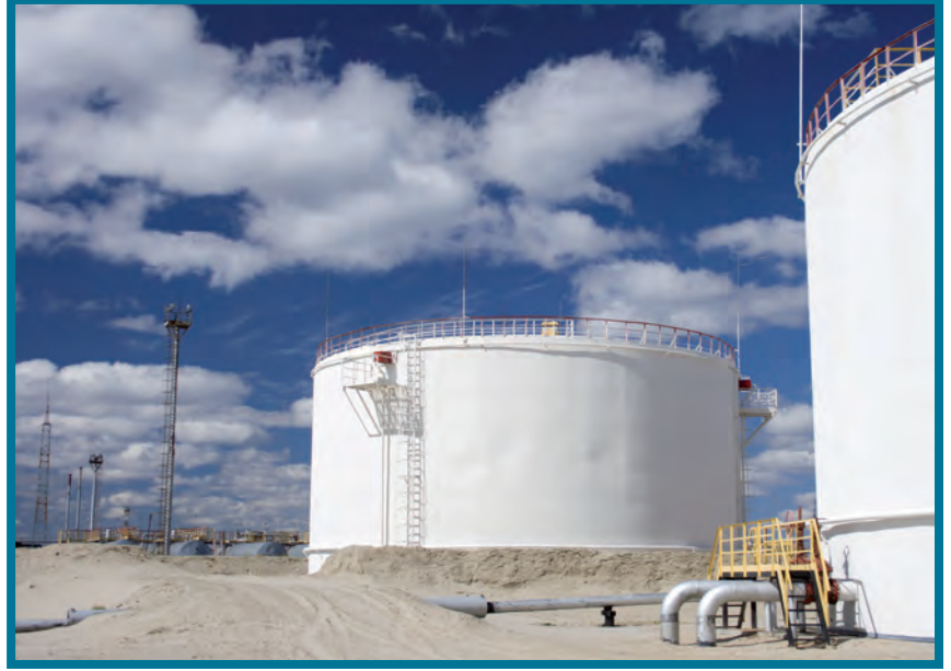
خزانات النفط في الكويت
